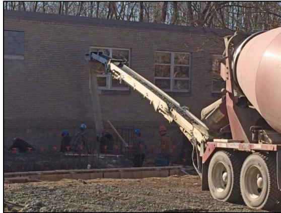
Pouring Concrete Footers
